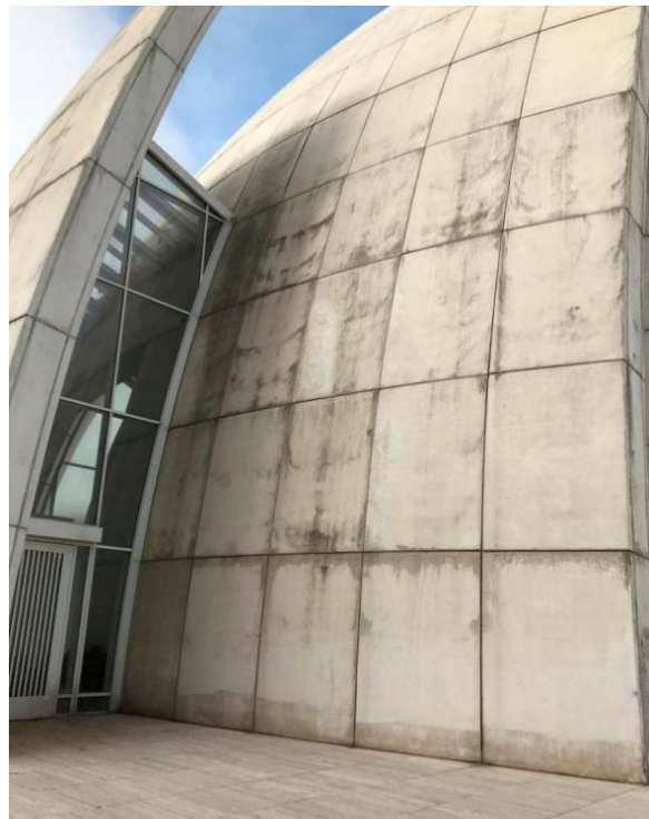
Рисунок 1.2 – Фасад церкви Dives on Misericordia в Риме спустя 16 лет эксплуатации
