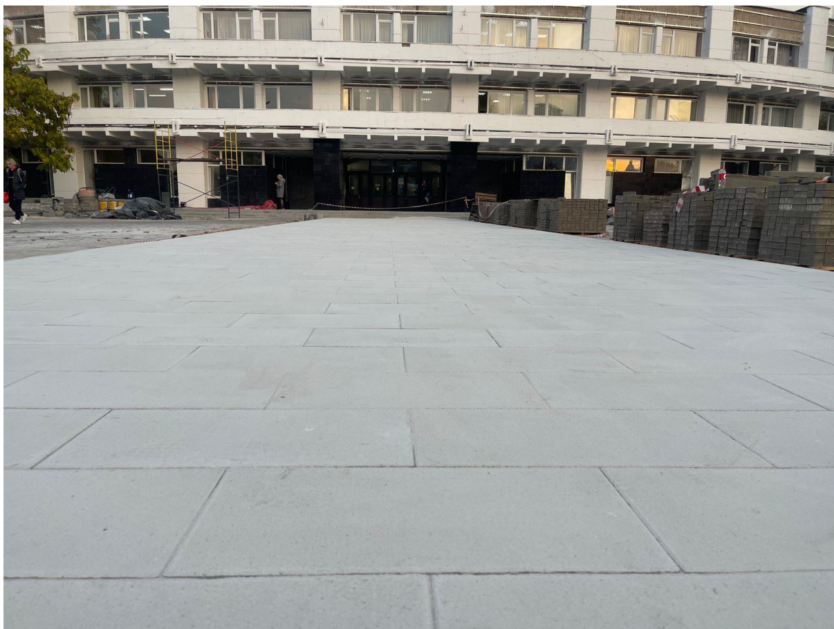
Рисунок 1.3 – Площадка из фотокаталитического бетона в г. Воронеж, площадь Детей
